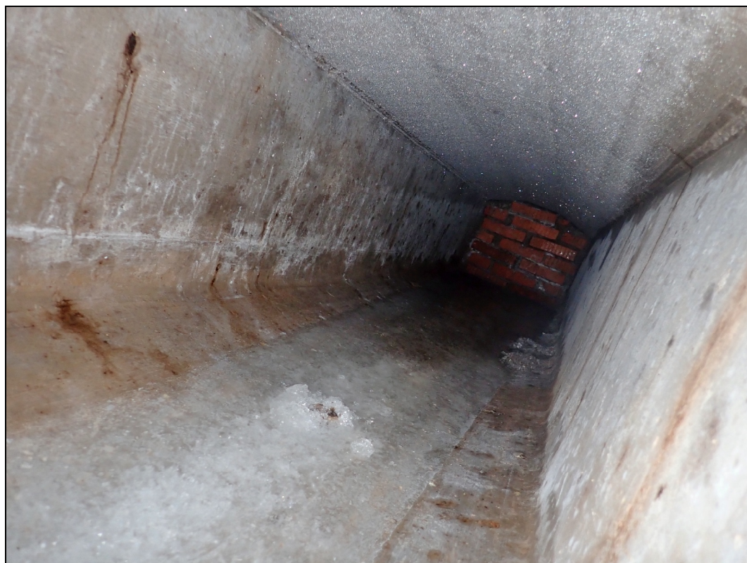
Foto 4: Detail vnitřního povrchu komory KA nosníku. Sonda 1. Uvnitř komory pozorovatelné výluhy a koroze měkké výztuže. Na dně komory vrstva ledu.
