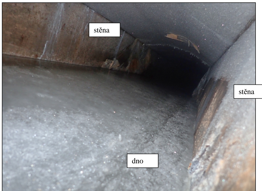
Foto 5: Detail vnitřního povrchu komory KA nosníku. Sonda 2. Uvnitř komory pozorovatelné výluhy a koroze měkké výztuže. Na dně komory vrstva ledu do cca 1/3 výšky komory.
