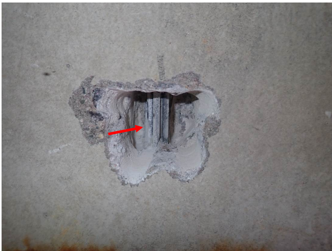
Foto 3: Detail sondy S3, předpínací výztuž nosník KA, 1. nosník od návodní strany, spodní líc. Na předpínací výztuži nebyla nalezena koroze. Kanálek zcela vyplněn injektážní směsí. Krytí předpínací výztuže cca 32 mm. Poloha viz Příloha 1.
