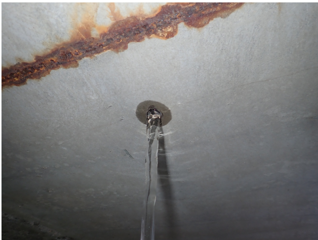
Foto 3: Detail vytékající vody po navrtání komor nosníků.
