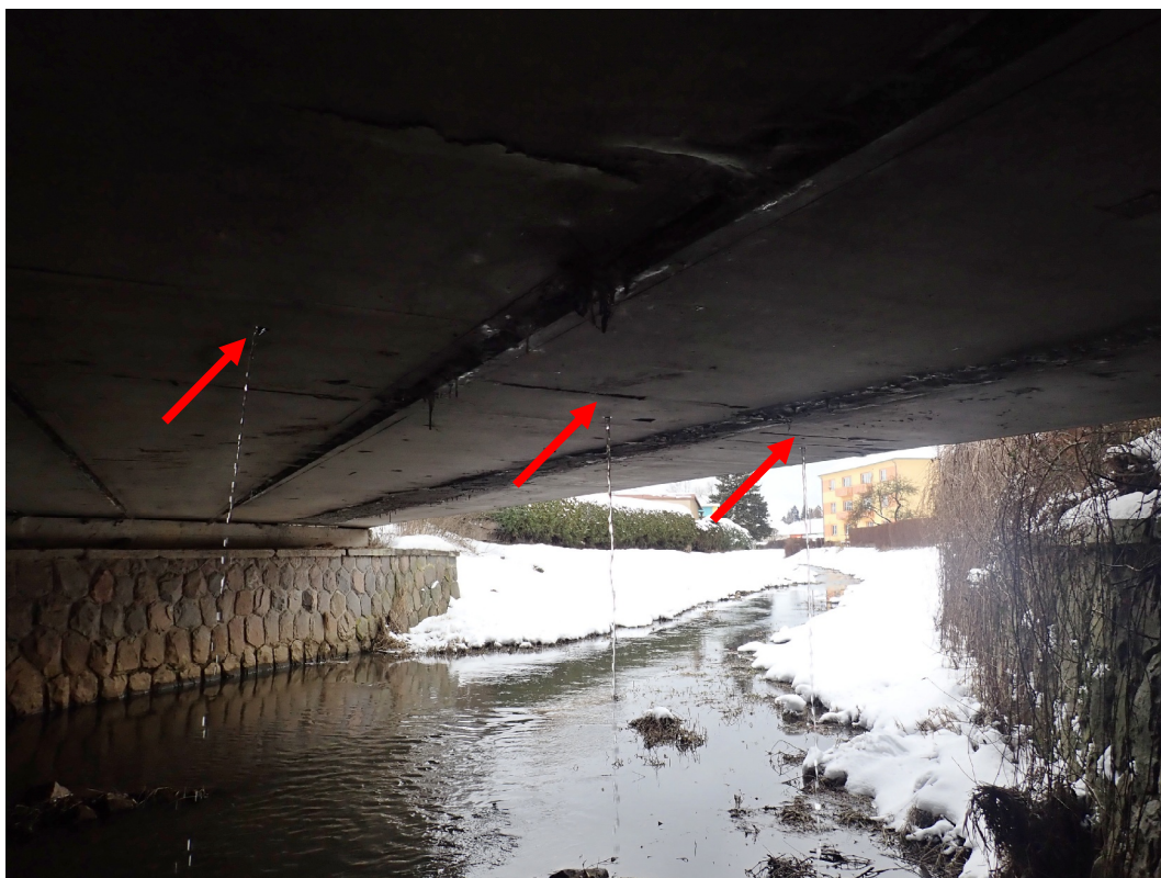
Foto 1: Detail vytékající vody po navrtání komor nosníků.
