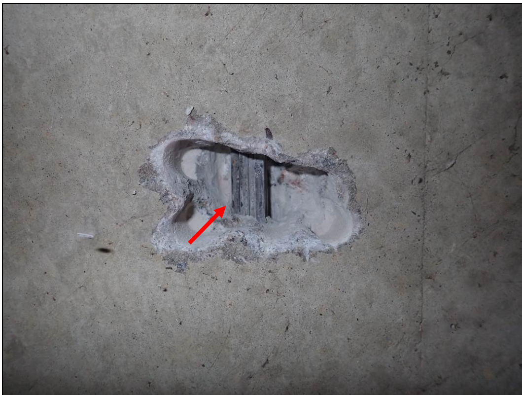
Foto 5: Detail sondy S5, předpínací výztuž nosník KA, 4. nosník od návodní strany, spodní líc. Na předpínací výztuži nebyla nalezena koroze. Kanálek zcela vyplněn injektážní směsí. Krytí předpínací výztuže cca 40 mm. Poloha viz Příloha 1.
