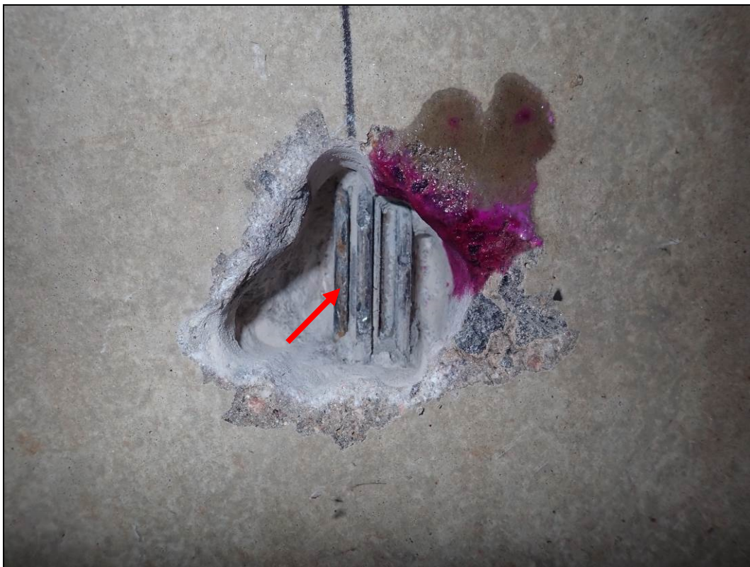
Foto 9: Detail sondy S9, předpínací výztuž nosník KA, 10. nosník od návodní strany, spodní líc. Na předpínací výztuži nebyla nalezena koroze. Kanálek zcela vyplněn injektážní směsí. Krytí předpínací výztuže cca 36 mm. Poloha viz Příloha 1.
