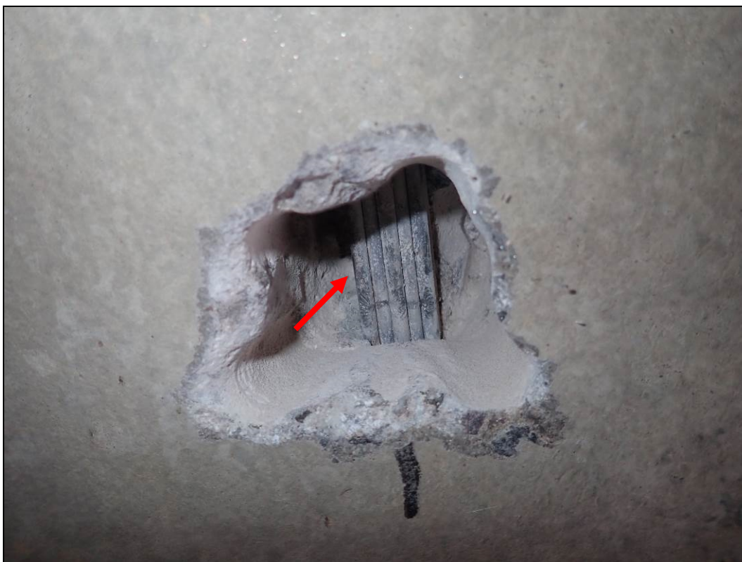
Foto 4: Detail sondy S4, předpínací výztuž nosník KA, 2. nosník od návodní strany, spodní líc. Na předpínací výztuži nebyla nalezena koroze. Kanálek zcela vyplněn injektážní směsí. Krytí předpínací výztuže cca 50 mm. Poloha viz Příloha 1.
