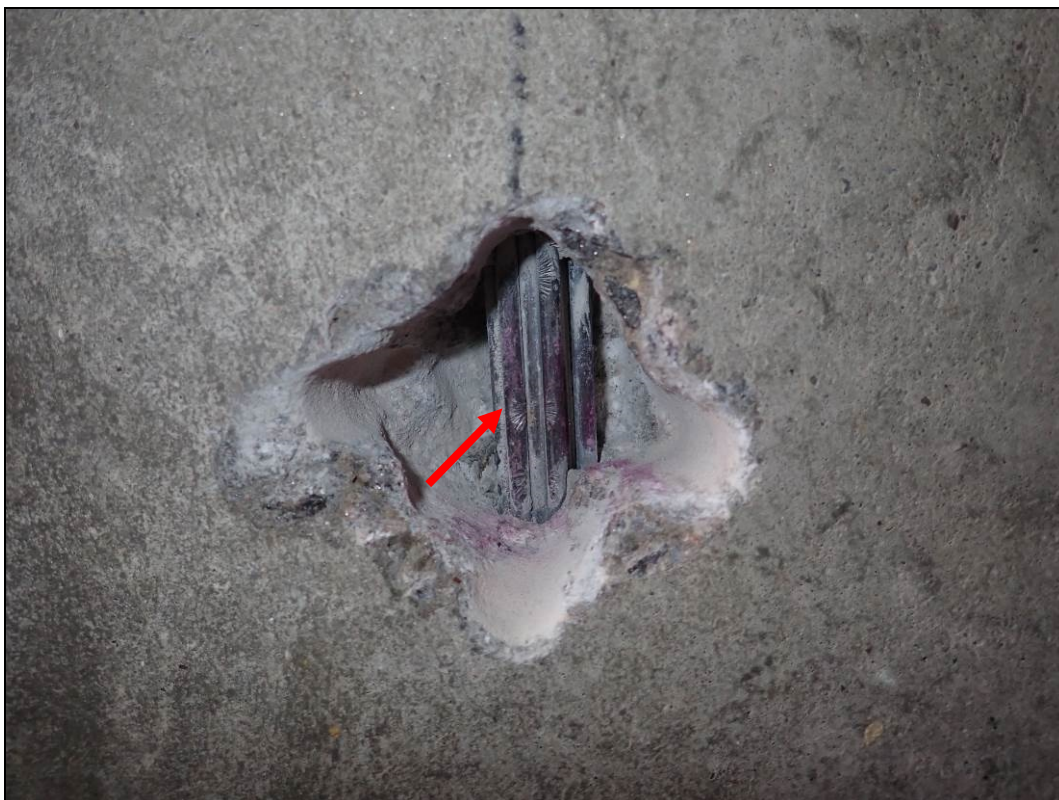
Foto 10: Detail sondy S10, předpínací výztuž nosník KA, 14. nosník od návodní strany, spodní líc. Na předpínací výztuži nebyla nalezena koroze. Kanálek zcela vyplněn injektážní směsí. Krytí předpínací výztuže cca 36 mm. Poloha viz Příloha 1.
