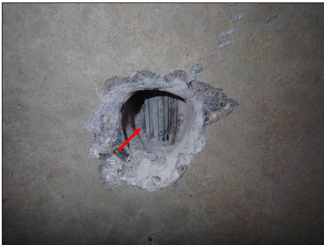
Foto 7: Detail sondy S7, předpínací výztuž nosník KA, 8. nosník od návodní strany, spodní líc. Na předpínací výztuži nebyla nalezena koroze. Kanálek zcela vyplněn injektážní směsí. Krytí předpínací výztuže cca 50 mm. Poloha viz Příloha 1.
