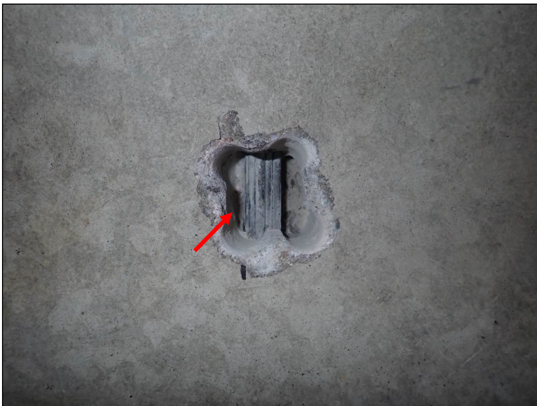
Foto 6: Detail sondy S6, předpínací výztuž nosník KA, 6. nosník od návodní strany, spodní líc. Na předpínací výztuži nebyla nalezena koroze. Kanálek zcela vyplněn injektážní směsí. Krytí předpínací výztuže cca 45 mm. Poloha viz Příloha 1.
