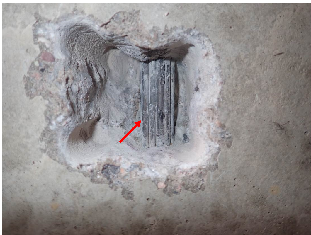
Foto 8: Detail sondy S8, předpínací výztuž nosník KA, 12. nosník od návodní strany, spodní líc. Na předpínací výztuži nebyla nalezena koroze. Kanálek zcela vyplněn injektážní směsí. Krytí předpínací výztuže cca 44 mm. Poloha viz Příloha 1.
