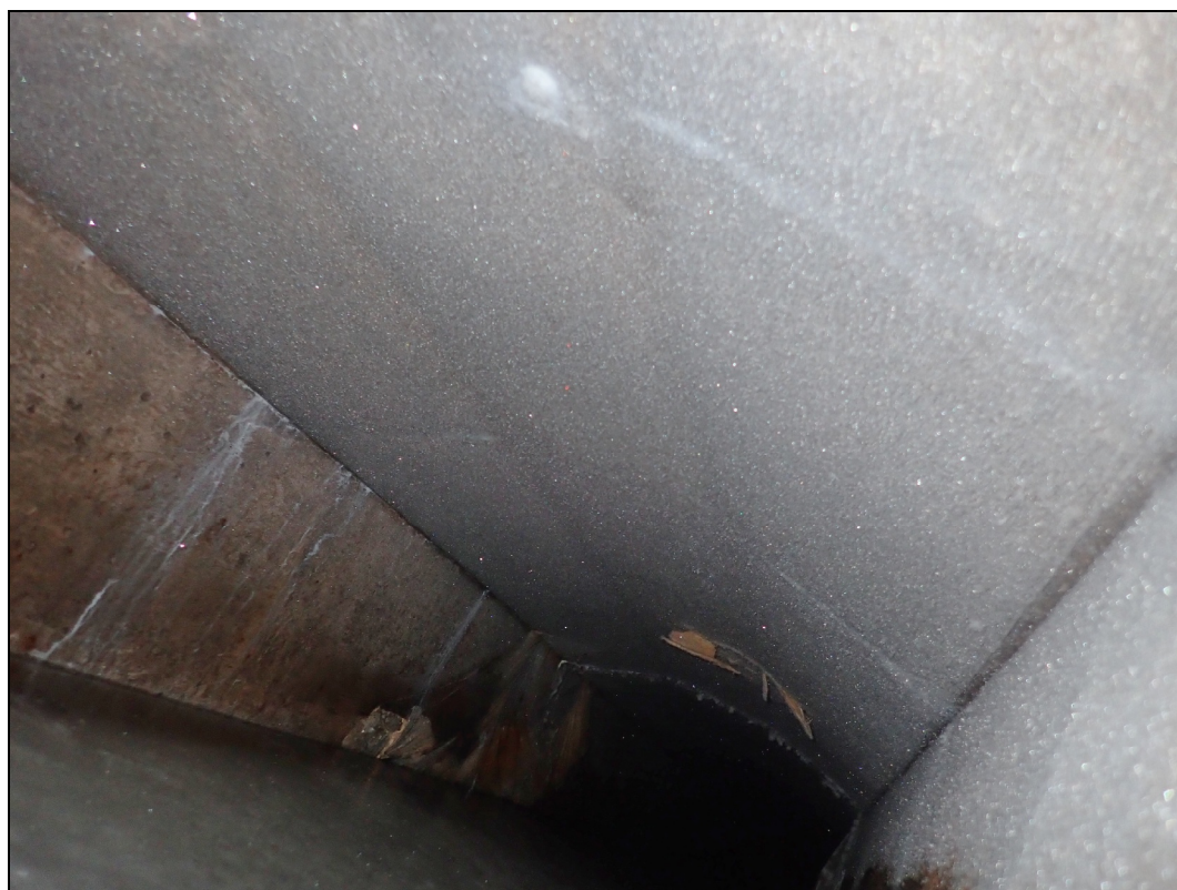
Foto 6: Detail vnitřního povrchu komory KA nosníku. Sonda 2. Uvnitř komory pozorovatelné výluhy a koroze měkké výztuže. Na dně komory vrstva ledu do cca 1/3 výšky komory.
