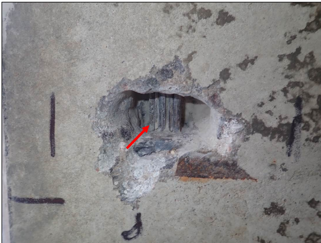
Foto 1: Detail sondy S1, předpínací výztuž nosník KA, 19. nosník od návodní strany, spodní líc. Na předpínací výztuži nebyla nalezena koroze. Kanálek zcela vyplněn injektážní směsí. Krytí předpínací výztuže cca 35 mm. Poloha viz Příloha 1.
