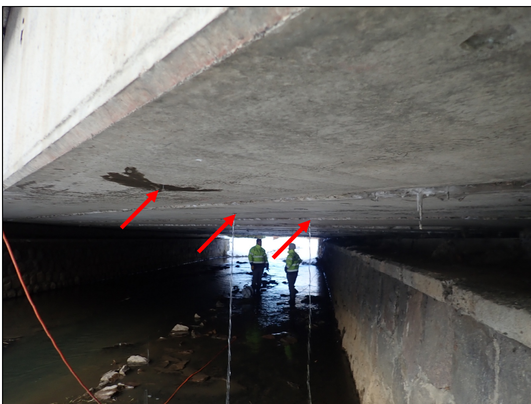
Foto 2: Detail vytékající vody po navrtání komor nosníků.
